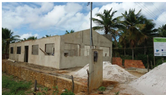
Construção da sede da Associação de Ouricuri, em Estância
