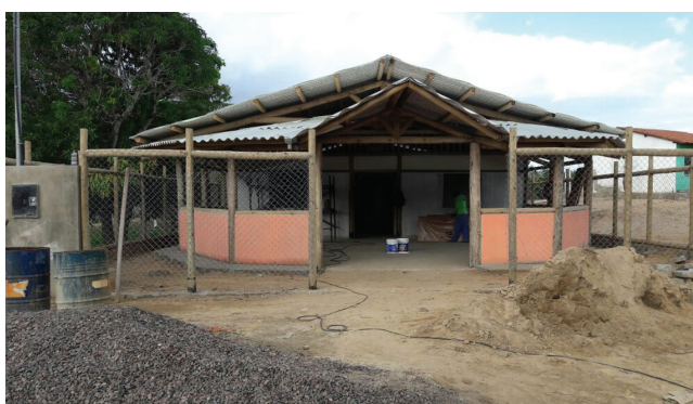
Fachada do Centro Comunitário de Piranhas (Pacatuba)
