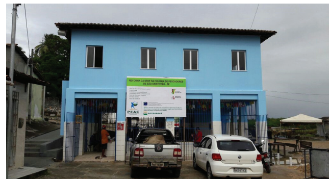
Reforma da Colônia de Pescadores de São Cristóvão, já próxima de sua conclusão.
