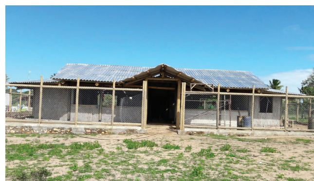
Construção do centro comunitário de Brejão dos Negros, em Brejo Grande
