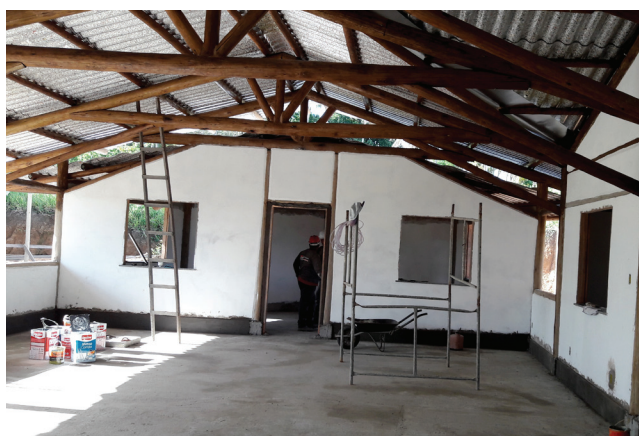
Centro Comunitário de Cachoeira já em fase de acabamento (Jandaíra-BA)
