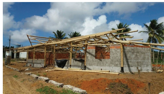
Construção do Centro Comunitário de Tibúrcio, em Estância
