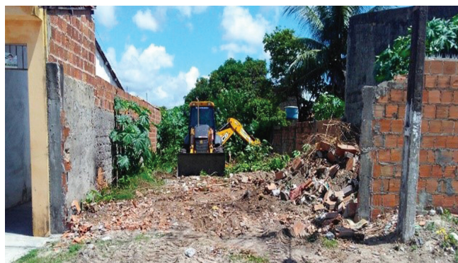
Construção da sede da Colônia de Barra dos Coqueiros
