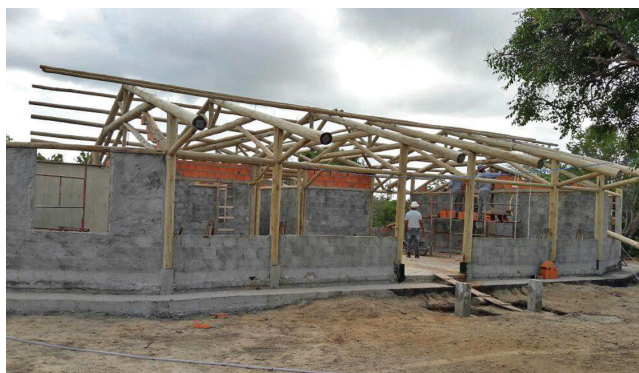
Construção do Centro Comunitário de Massadiço, em Estância
