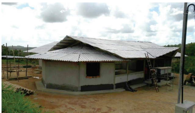
Construção do Centro Comunitário de Abadia (Jandaíra-BA)
