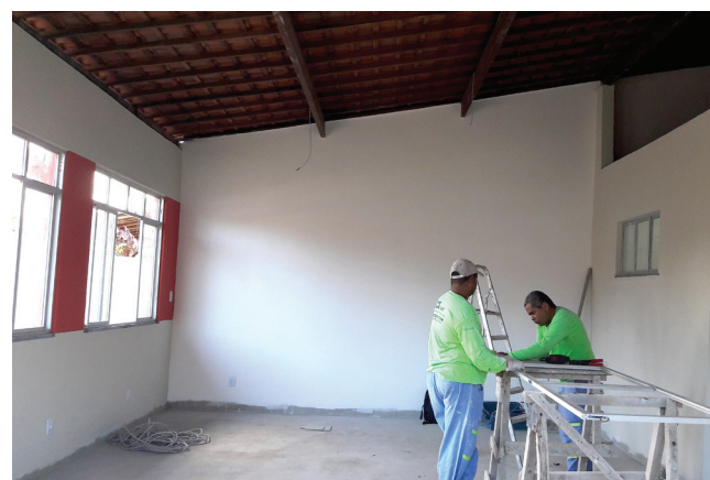
Fachada e interior Sede da Associação de Aracaré/Oitizeiro/Garatuba, em Pacatuba
