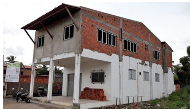
Construção da sede da Associação das Catadoras de Mangaba de Barra dos Coqueiros
