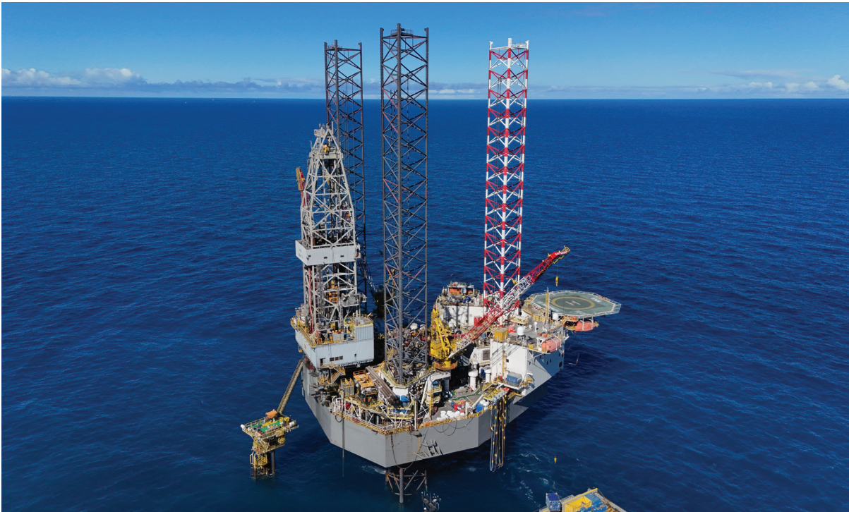
A plataforma auto elevatória PA-39, que atua no Campo de Camorim
