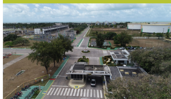
Instalações localizadas no Polo Atalaia
