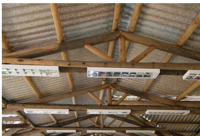
Detalhes da obra no centro
