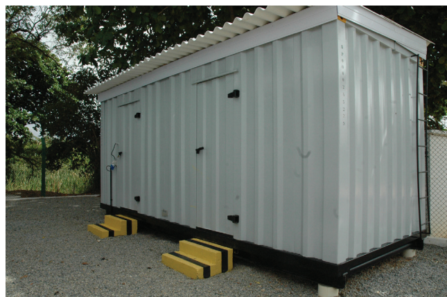
Área de reabilitação no Polo Atalaia da Petrobras
