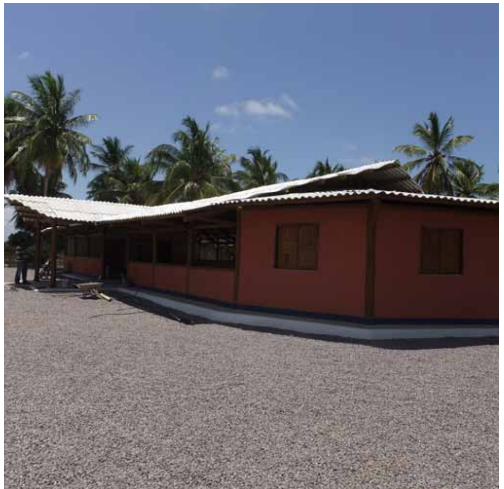
Vista lateral do Centro Comunitário Norte, localizado em Pacatuba
