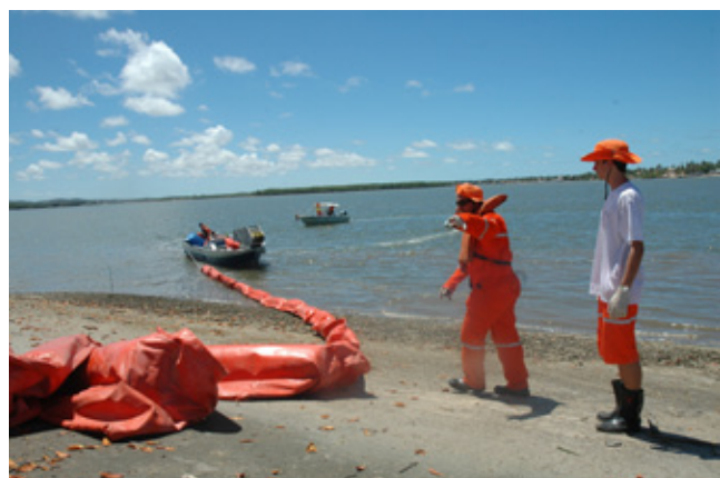
Montagem de barreira na margem do rio Vaza-Barris e deslocamento para proteção de estuário
