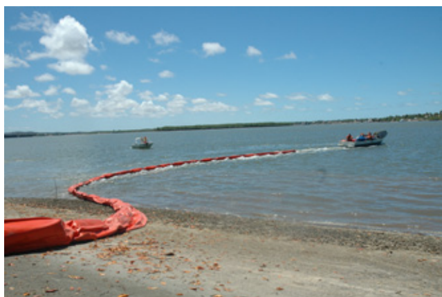
Montagem de barreira na margem do rio Vaza-Barris e deslocamento para proteção de estuário
