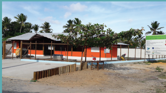
Centro Comunitário de Pedra Furada
