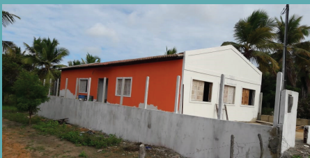
Construção da sede da Associação de Moradores em Ouricuri
