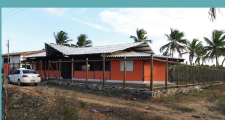
Construção de Centro Comunitário em Tibúrcio
