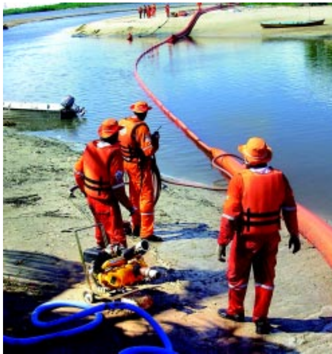
Montagem de barreiras em área de estuário
